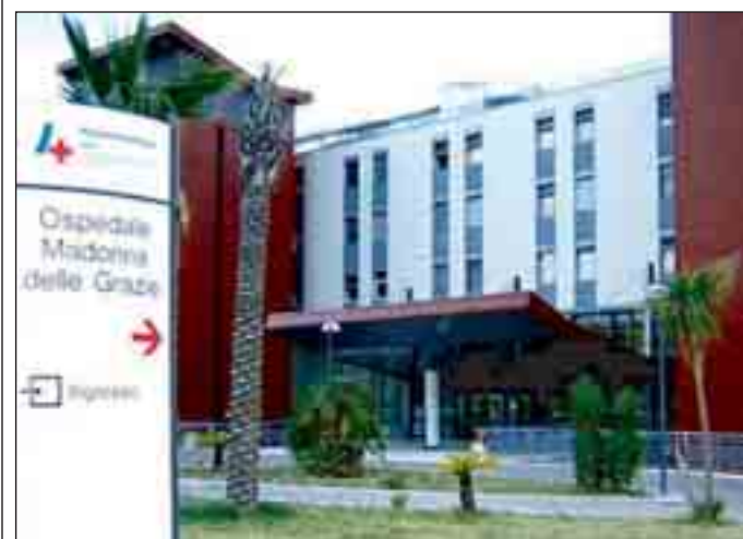
La struttura ospedaliera di Matera
